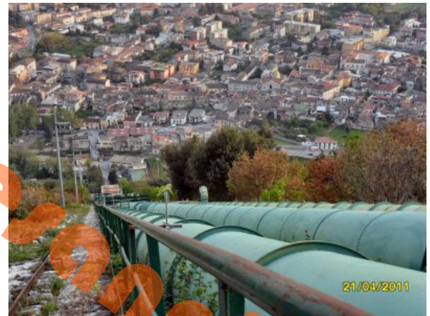
Foto 14 negli ultimi 140 metri abbiamo trovato discontinuità per oltre 40 metri anche se gli ultimi 50/60 metri appaiono piuttosto ben conservati.
